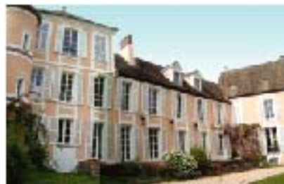
Le bâtiment de Montfort-Lamaury avant réhabilitation
